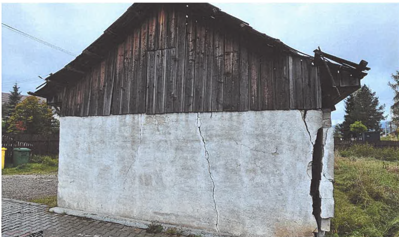
Foto 04 – Aspecte exterioare: vedere de ansamblu fatade
