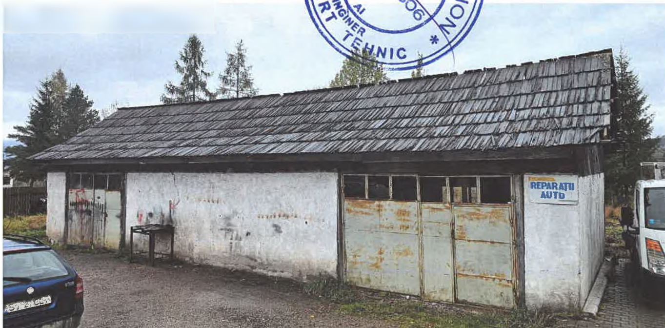
Foto 01 – Aspecte exterioare: vedere de ansamblu fatade
