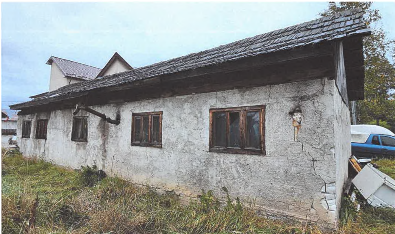
Foto 03 – Aspecte exterioare: vedere de ansamblu fatade
